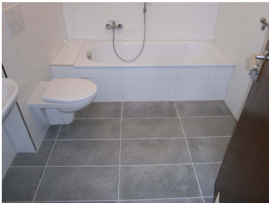
Oben altes Bad – unten Bad nach Sanierung
